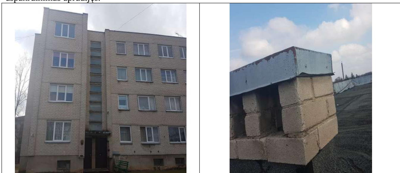
Sutapdintas stogas nešiltintas. Nuolydžiai suformuoti neteisingai.
