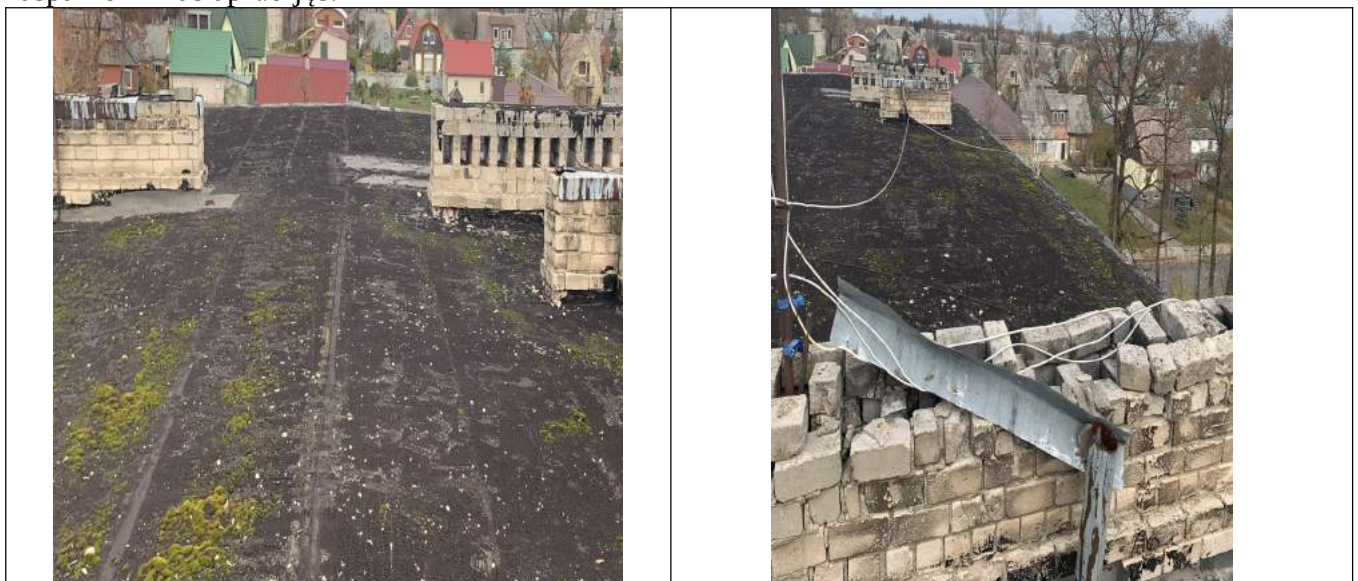
Sutapdintas stogas nešiltintas. Nuolydžiai suformuoti neteisingai.
